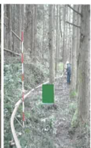
モノレールによる機材搬入の例
